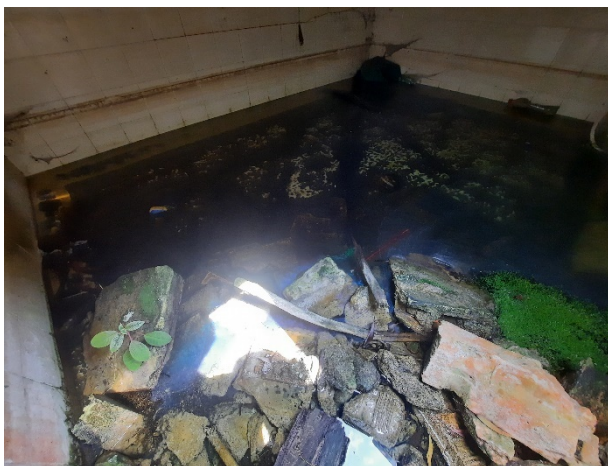
Foto No. 7 Vista interna tanque de almacenamiento
