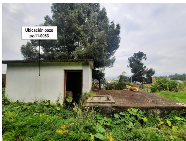
Foto No. 3. Ubicación pozo pz-11-0083
